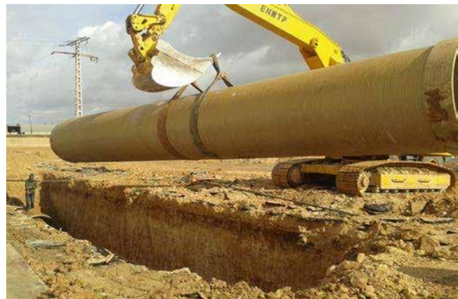
Réhabilitation du réseau d'assainissement de la ville de Laghouat DN 1600 - PN 06 - SN 5000
