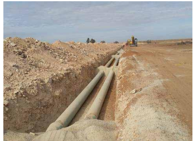
Adduction d'eau potable, El Birine- Aïn El Hedjel Bouti Sayeh (Wilaya de M'sila) DN 400 et 500 - PN 16 et 20
