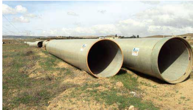
Périmètre hydro-agricole de Ksar Sbihi Oum El Bouaghi Tuyaux et raccords DN 1400 - PN 10 - SN 10 000
