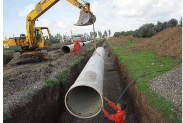
Conduite de refoulement Couloir Douéra - El Harrach Fourniture et pose DN 1000 - PN 10
