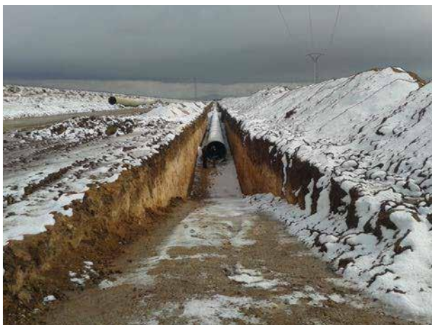
Transfert Aïn El Kercha-Ourkiss Fourniture et pose tuyaux et raccords DN 1600 - PN 10, 16 et 25
