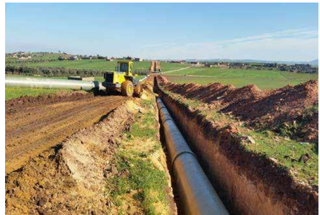
Adduction des eaux déssalées de la Wilaya de Mostaganem vers la wilaya de Relizane DN 800,1000 et 1200 - PN 25
